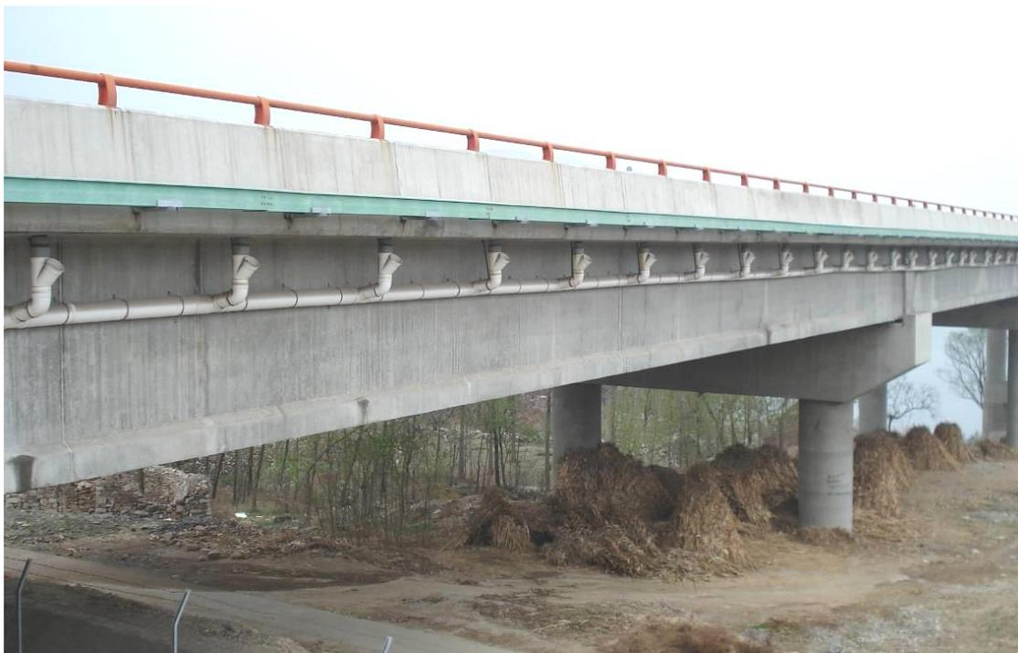
图 8.5-1 径流收集系统实景照片
