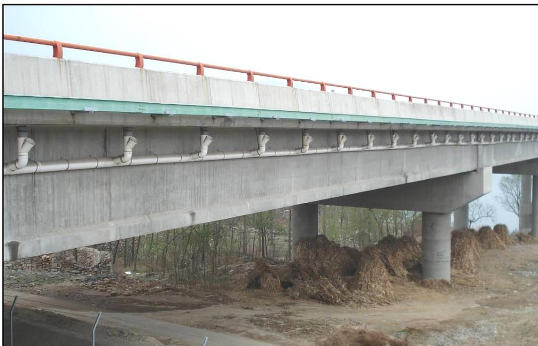
图 3.8-2 径流收集系统实景照片
