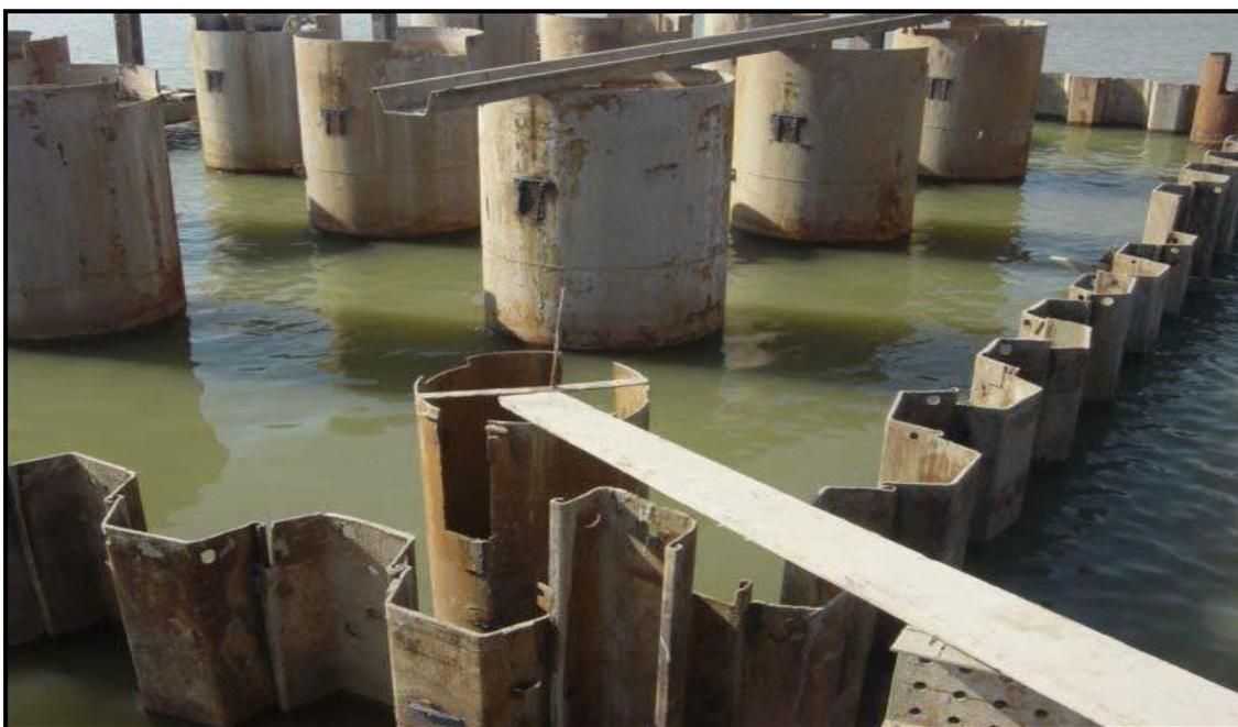
图 3.7-2 河流内桥梁桩基施工围堰现场照片
